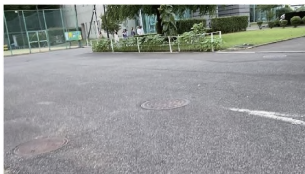
図3 アスファルト
